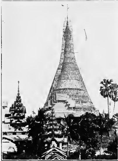
217. PLASTERER'S SCAFFOLD ON ZEDI.
